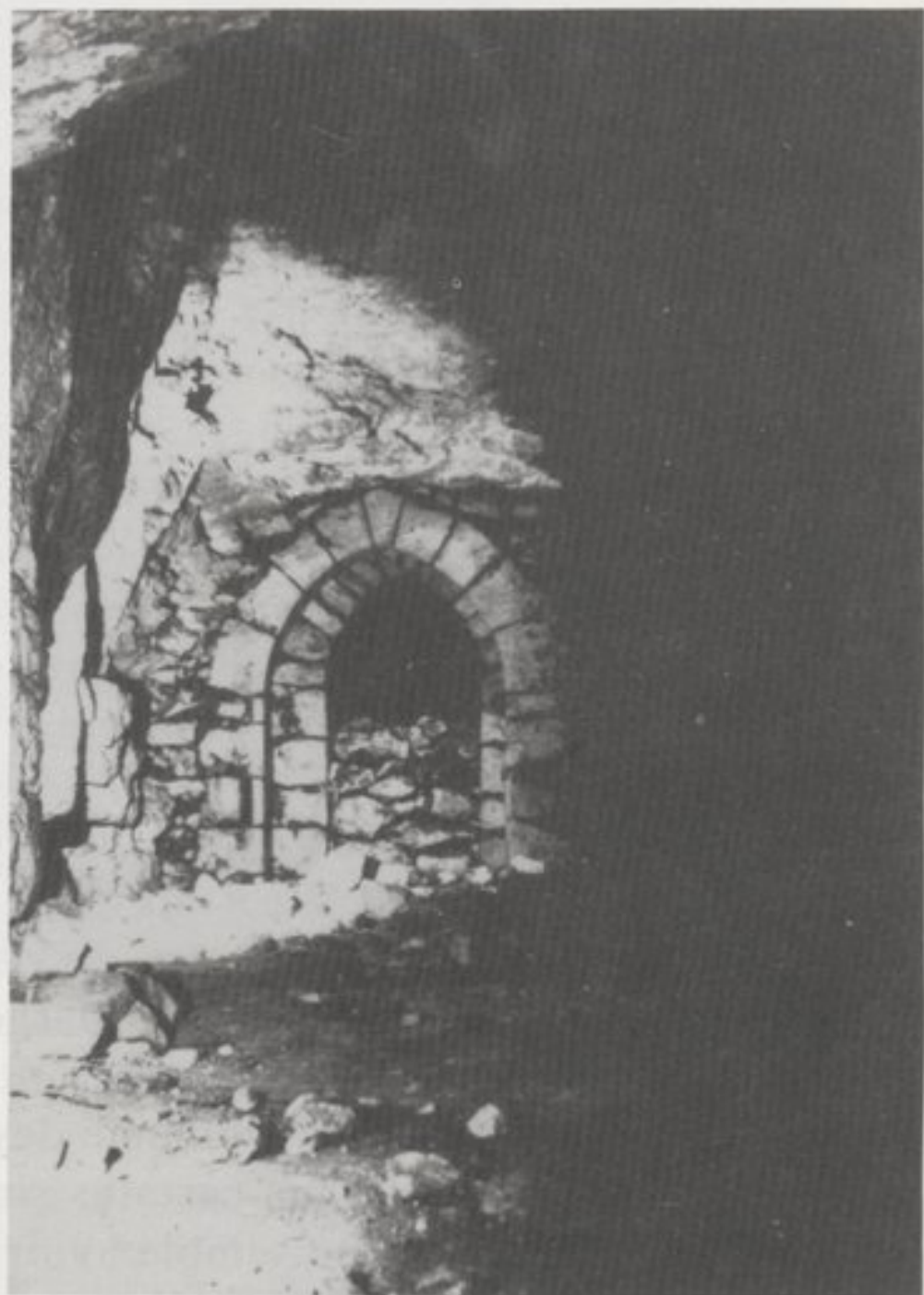
Grande salle de Beauvais (Draché), au fond l'arc appareillé en ogive du couloir d'accès. Dans la paroi droite de ce couloir débouchent deux meurtrières, celles-ci, contrôlées depuis l'intérieur du souterrain, devaient permettre d'anéantir bon nombre d'assaillants.
