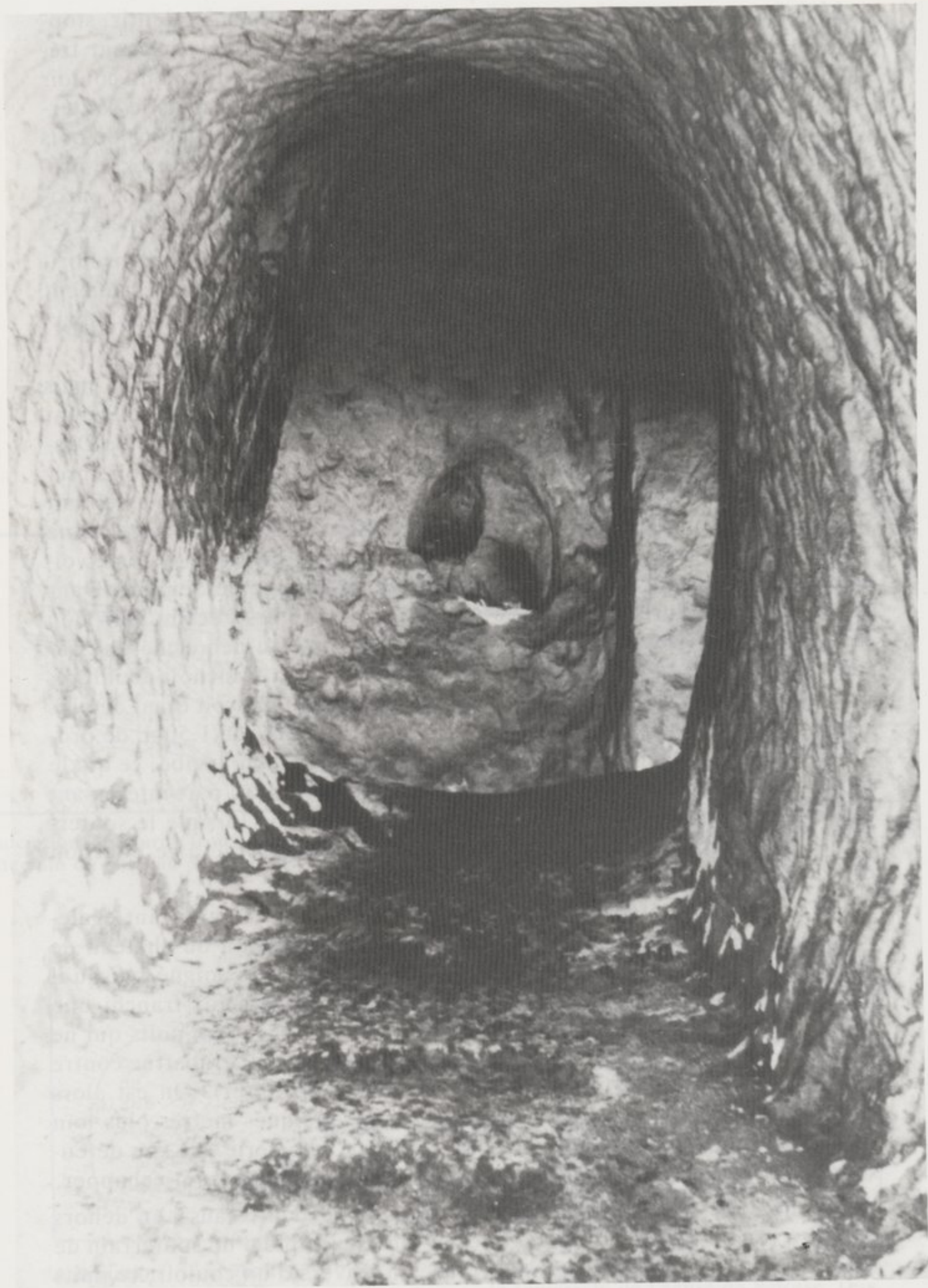
Crissay-sur-Manse, souterrain du château. Escalier remontant des salles terminales, débouchant dans la salle B face à l'appui en forme d'écusson permettant le contrôle de deux trous de visée. (Photographie L. Triolet).
