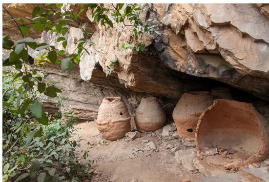
Fig. 7 : Dans l'abri sous roche constituant l'essentiel de la grotte de Oyira, les cinq silos en banco, qui auraient été construits dans les années 1920-1930, sont en bon état, excepté l'un d'entre eux aujourd'hui éventré (photo J. & L. Triolet).
