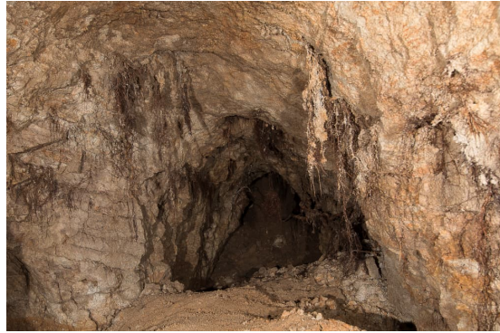
Fig. 4 : Comme la majeure partie du souterrain, ce couloir-salle (D) est en très mauvais état. L'arénisation du granite et les racines qui pénètrent depuis la surface entraînent l'effondrement progressif des voûtes et des parois. Hauteur : environ 1,30 m (photo J. & L. Triolet).
