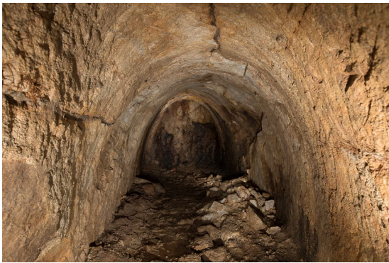
Fig. 3 : Ce couloir-salle bien conservé et dépourvu d'aménagements (B) est très similaire à ceux du souterrain-refuge voisin du Fief. Hauteur : 1,65 m (photo J. & L. Triolet).
