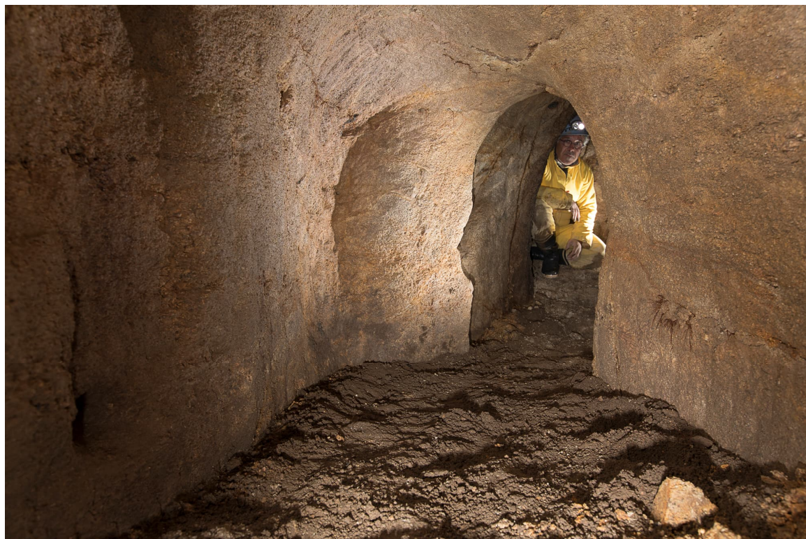
Fig. 1 : Dans le couloir d'accès, juste avant la deuxième feuillure (F2), le renforcement sur la gauche ainsi que le changement d'axe et de gabarit correspondent très certainement à un raccord de creusement. Cette partie du souterrain est creusée dans un granite de bonne qualité (photo J. & L. Triolet).
