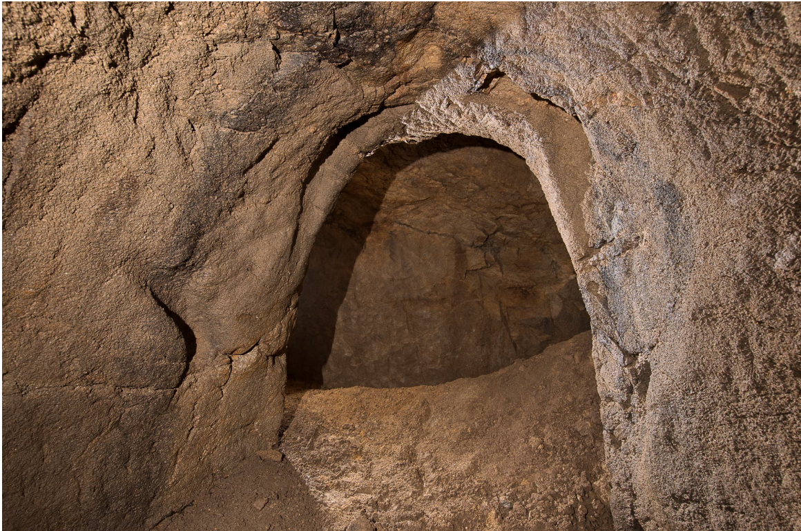
Fig. 7 : Vue depuis l'intérieur de la chambre (H), la petite feuillure (F5) qui permettait autrefois de la séparer du grand couloir-salle (G), sans doute au moyen d'une cloison de bois et de torchis percée d'une porte. Hauteur : 1,65 m (photo J. & L. Triolet).
