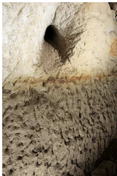
Dans les derniers mètres de la descente, du fait du gabarit du boyau et de la diaclase, la progression accroupie est particulièrement difficile. C'est à ce niveau, dans la paroi de droite, que débouche l'orifice du trou de visée (t) ; L'Aumont (photo J. & L. Triolet)
