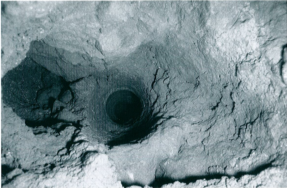
Souterrain-refuge de l'église de Chérancé : tuyau d'aération constitué d'éléments en céramique emboîtés, en place dans le puits d'extraction P1.
